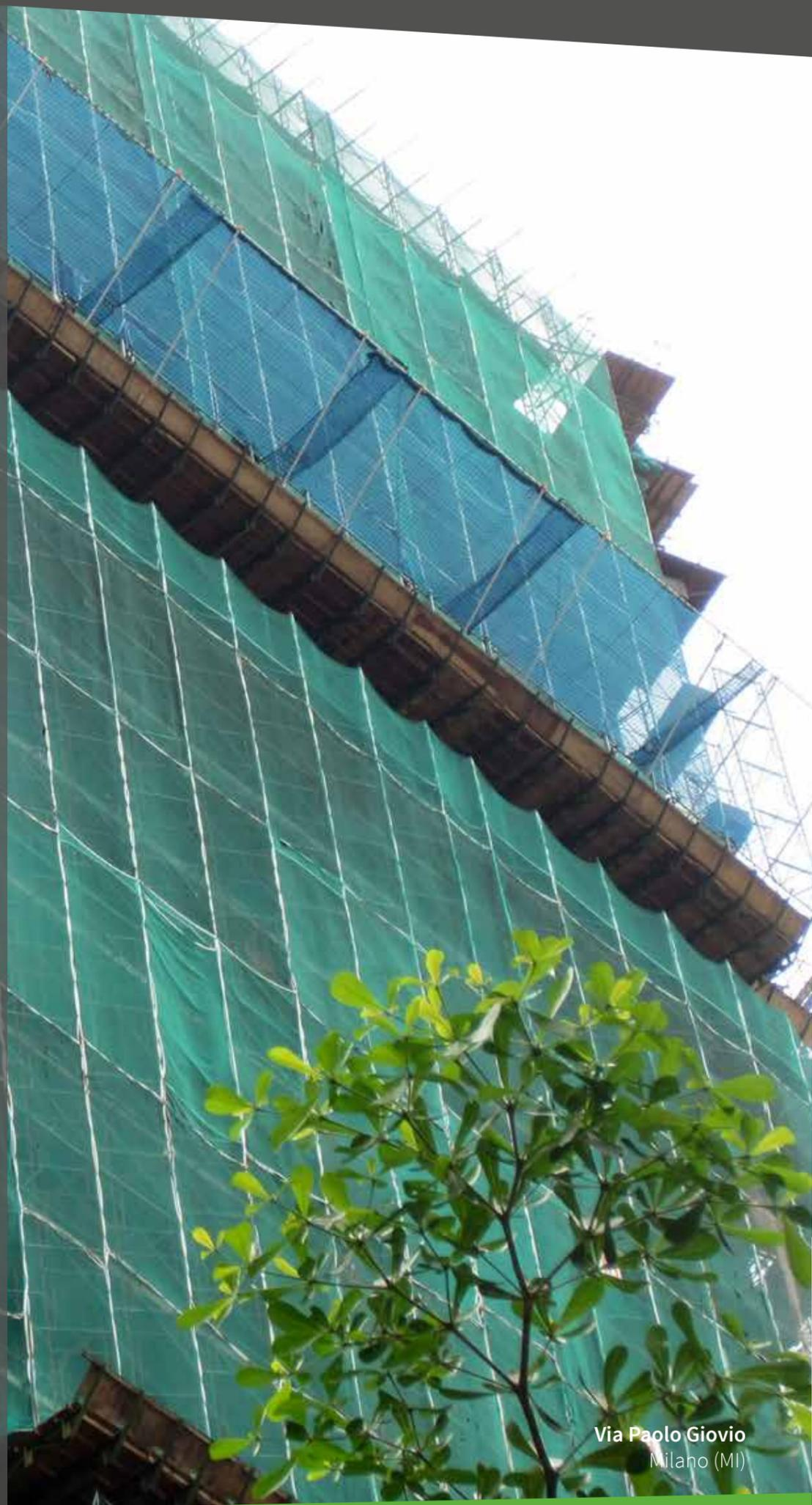
Le reti anticaduta sono il sistema più utilizzato per la messa in sicurezza di **LUCERNARI**, **PONTEGGI** e **SCAFFALATURE** e sono usate anche nei luoghi di lavoro dove gli operatori devono avere piena libertà di movimento ma devono essere protetti con sistemi atti ad **ARRESTARE LA CADUTA**.
