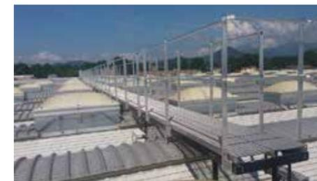
**Norme di riferimento:** le passerelle e i camminamenti sono progettate e costruite secondo quanto disposto dal D.Lgs 81/08, NTC e dalla norma UNI EN ISO 14122-2 "Mezzi di accesso permanenti al macchinario - parte 2: piattaforme di lavoro e corridoi di passaggio".
